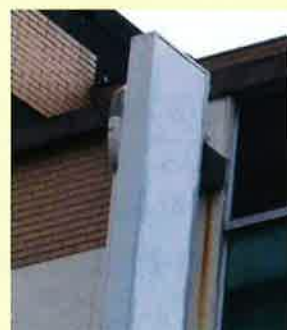
↑ 壁のサビ汁汚れは内部の 取付金具が腐食
